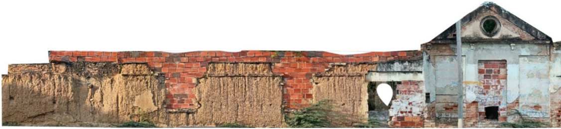
Ilustración 17. FACHADA ESTACIÓN K14. ELABORACIÓN PROPIA
