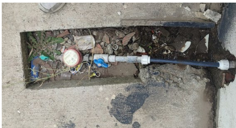
Figura 12 acometida acueducto veredal quiba alto.
