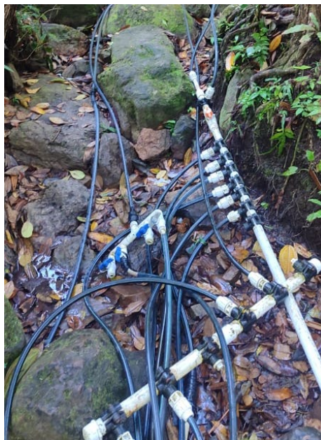
Figura 15 acoples caseros para la distribución del agua en Viotá.
