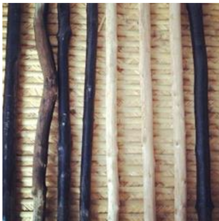
Figura 45 Techos artesanales suspendidos por entramados de caña tejida.
