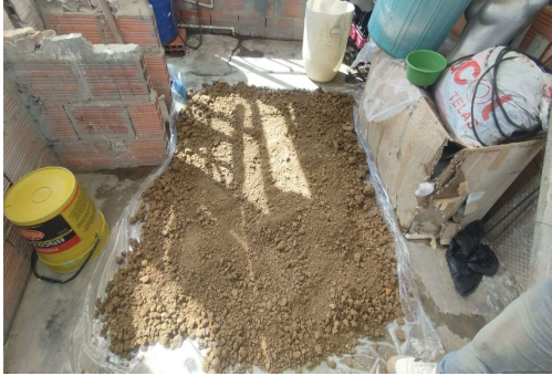
Ilustración 20. Preparación de materia, secado de arcilla
