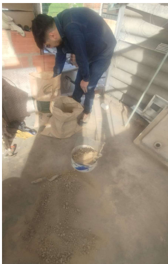
Ilustración 64. Separación de impurezas
