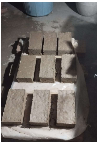
Ilustración 69. Desmolde de los bloques
