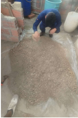
Ilustración 24. Trituración de la arcilla
