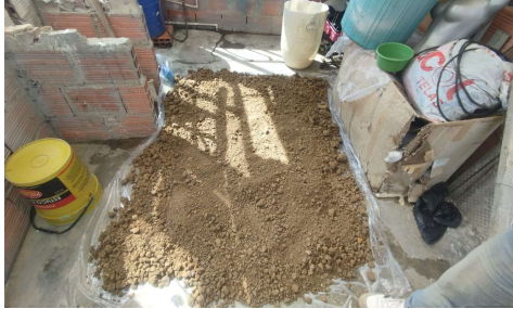
Ilustración 58. Secado de arcilla
