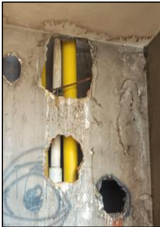
Figura 61 Cambio de Tubería sanitaria edificio Bloque C-1 y C-2 administración. Ramírez 2024.
