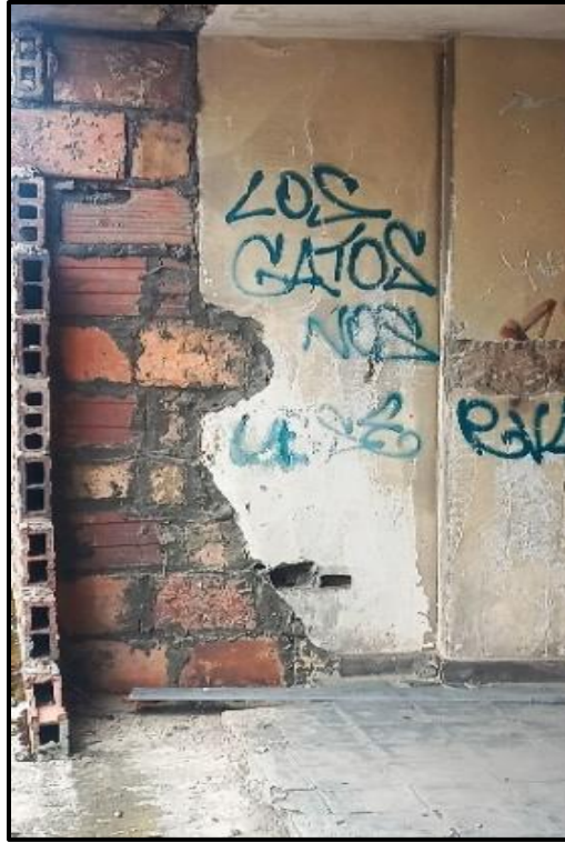
Figura 56 Parte División Muros Bloque Arcilla CUAN Bloque C-2 Piso 3. Ramírez 2024.
