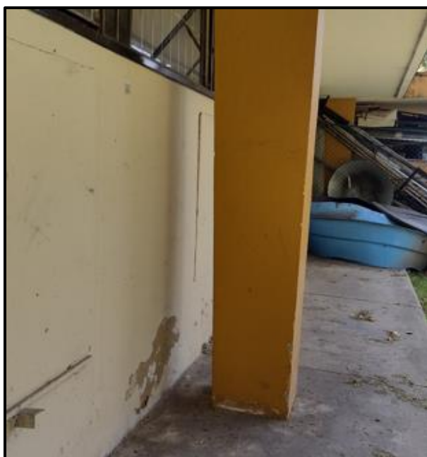
Figura 65 Columnas sólidas, de la construcción original, cimentación con pilotes. Ramírez 2024.
