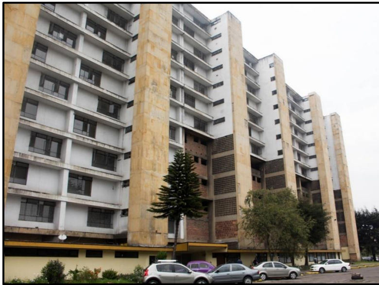
Figura 63 Fachada original de las Residencias Universitarias. Ramírez 2024.
