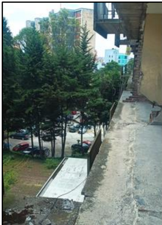
Figura 58 Presencia de árboles fuera del bloque C-1 y C-2 Ramírez 2024.
