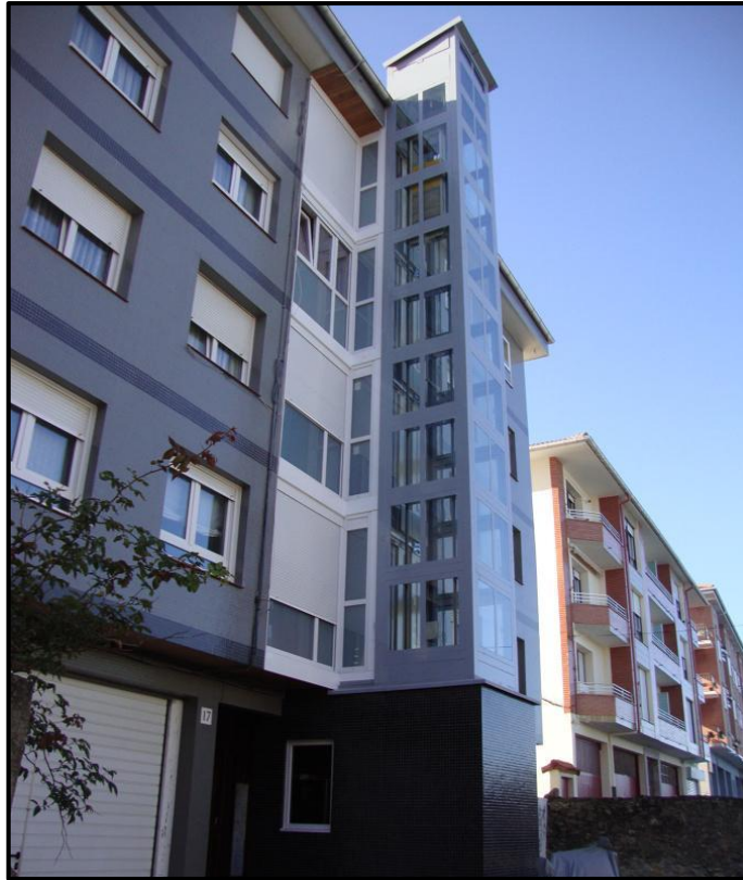
Figura 78 Implementación de estructura en Altura para Ascensor Panorámico.
