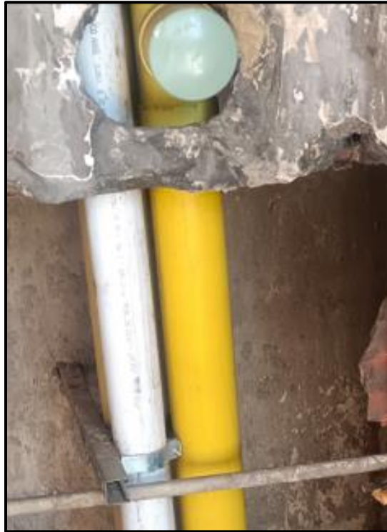
Figura 61 Cambio de Tubería sanitaria edificio Bloque C-1 y C-2 administración. Ramírez 2024.
