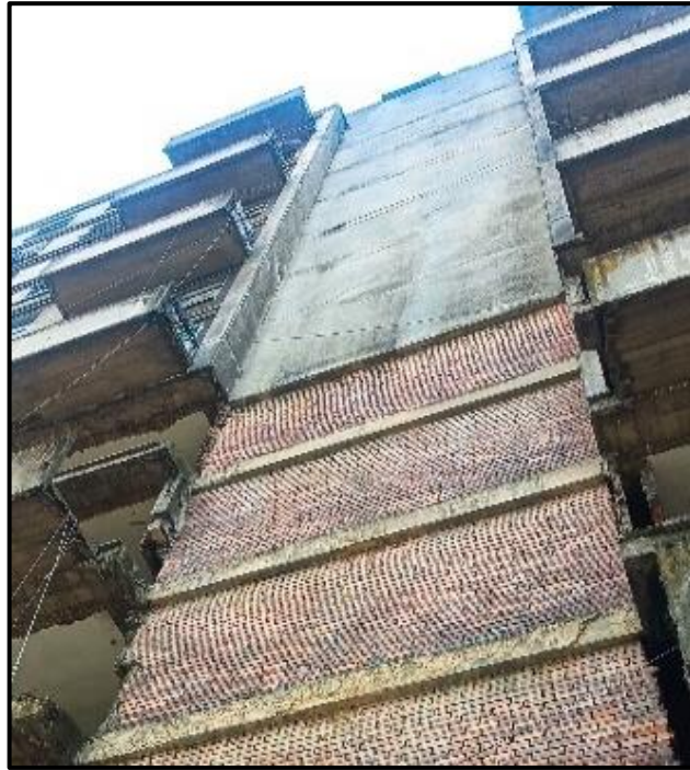
Figura 71 Los Muros en Ladrillo a la vista. Ramírez 2024.
