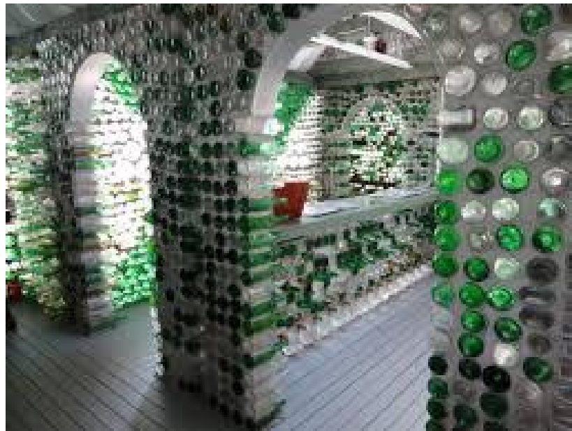
Figura 20. Muros con envases de vidrio.
