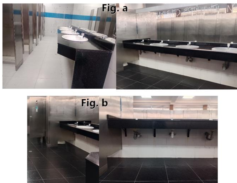
Figura 27. Lavamanos de los baños de la UCMC
