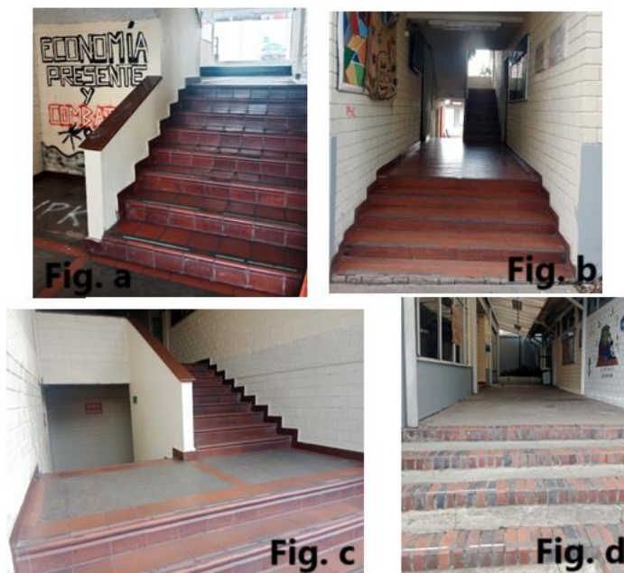
Figura 13. Escaleras Internas de los Edificios
