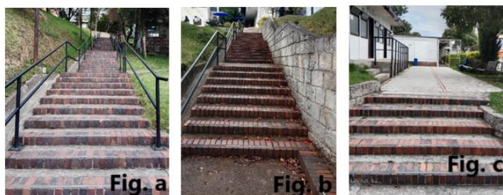
Figura 5. Escaleras Exteriores Sector Sur.
