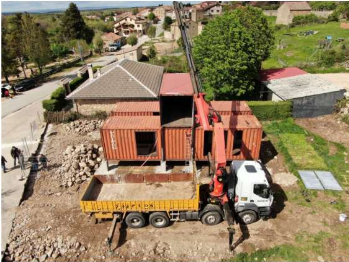
Imagen del montaje de los contenedores - Foto: D.S.
