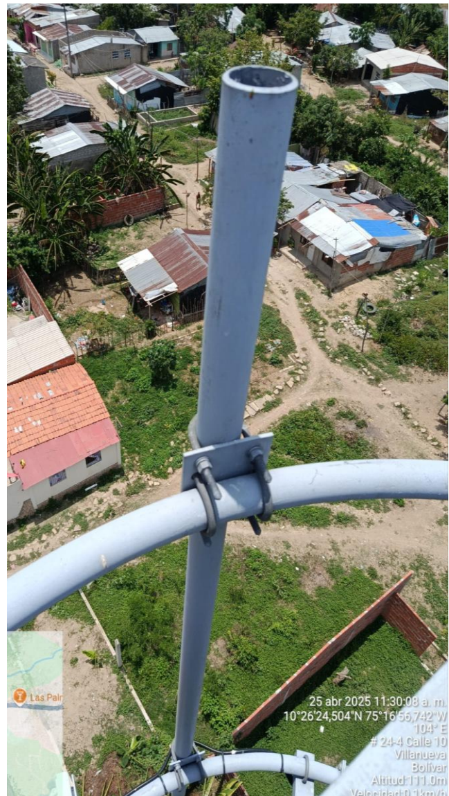
Figura 39 soporte en torre. Autor ingytelcom. Abril 2025
