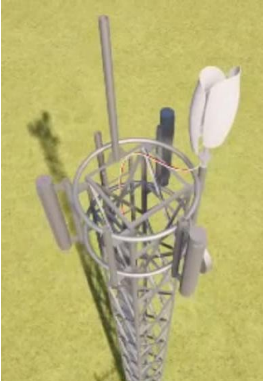
figura 56. torre de telecomunicaciones con sistema implementado. Autores. Marciales, Mican y Robayo. 2025
