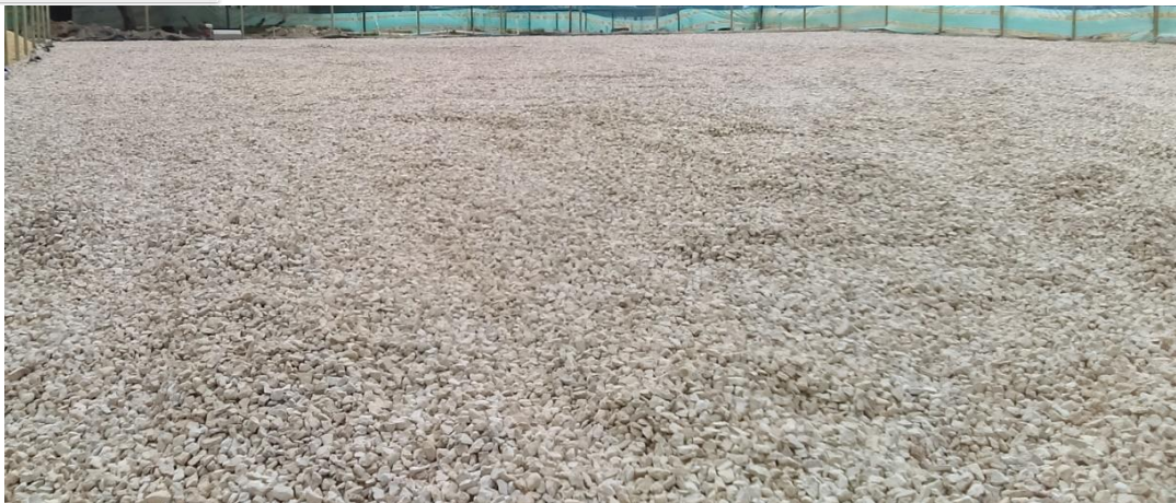
Ilustración 20 Lecho filtrante con grava (2019). Fuente: Propia
