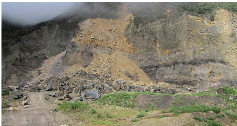
Ilustración 24 Una cantera ilegal tiene en peligro a un barrio en Usme (2019)
