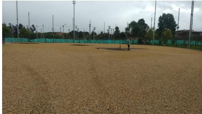
Ilustración 28 Lecho filtrante en grava (2019) Fuente: Propia
