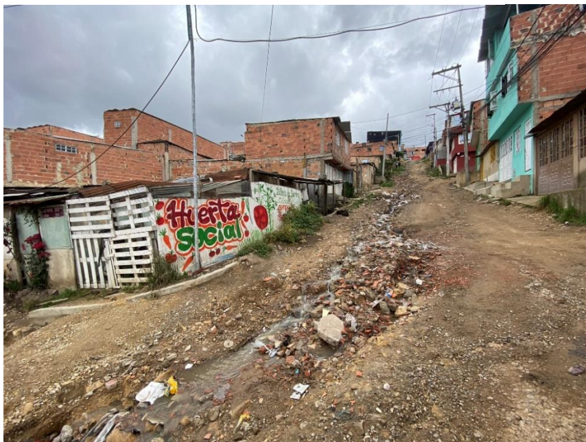
Figura 33 Erosión y sedimentación por escorrentía.
