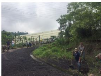
Figura 4: Fotografía Construcción de la vía veredal. Fotografía Eugenia, B. (2020)
