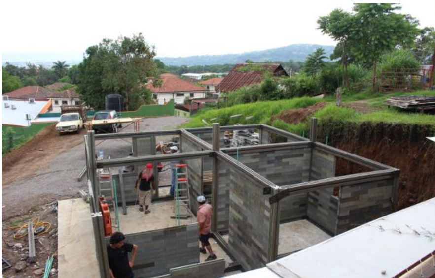
Figura 31 Construcción vivienda con ladrillos plásticos
