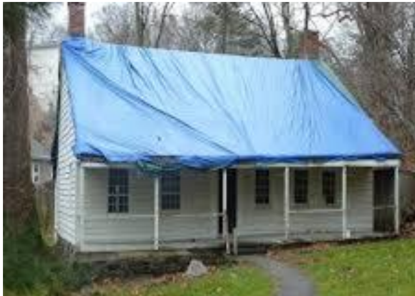
Figura 16 Viviendas con protección en techos con lona. P, gobierno. 2017
