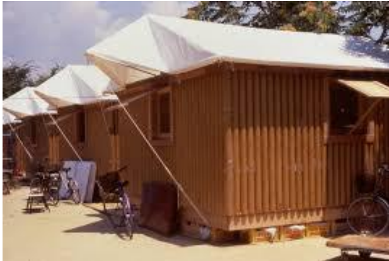
Figura 13 Vivienda de emergencia Madera y Guadua. Relief. 2004
