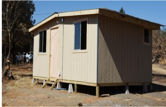
Figura 25 Vivienda tras incendio forestal. El Mostrador. 2025
