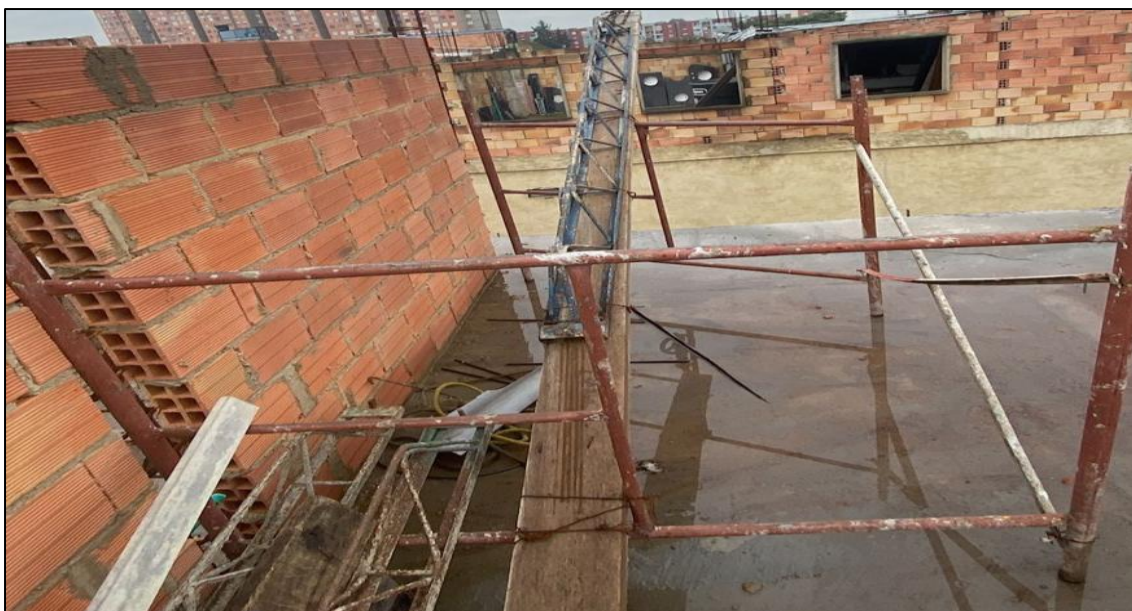
figura 18; Andamio tubular no certificado
