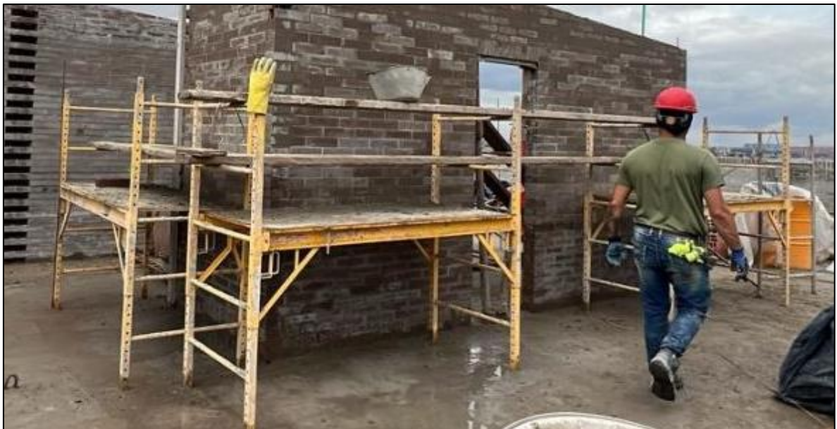
figura 21;Andamio tubular con plataforma certificado
