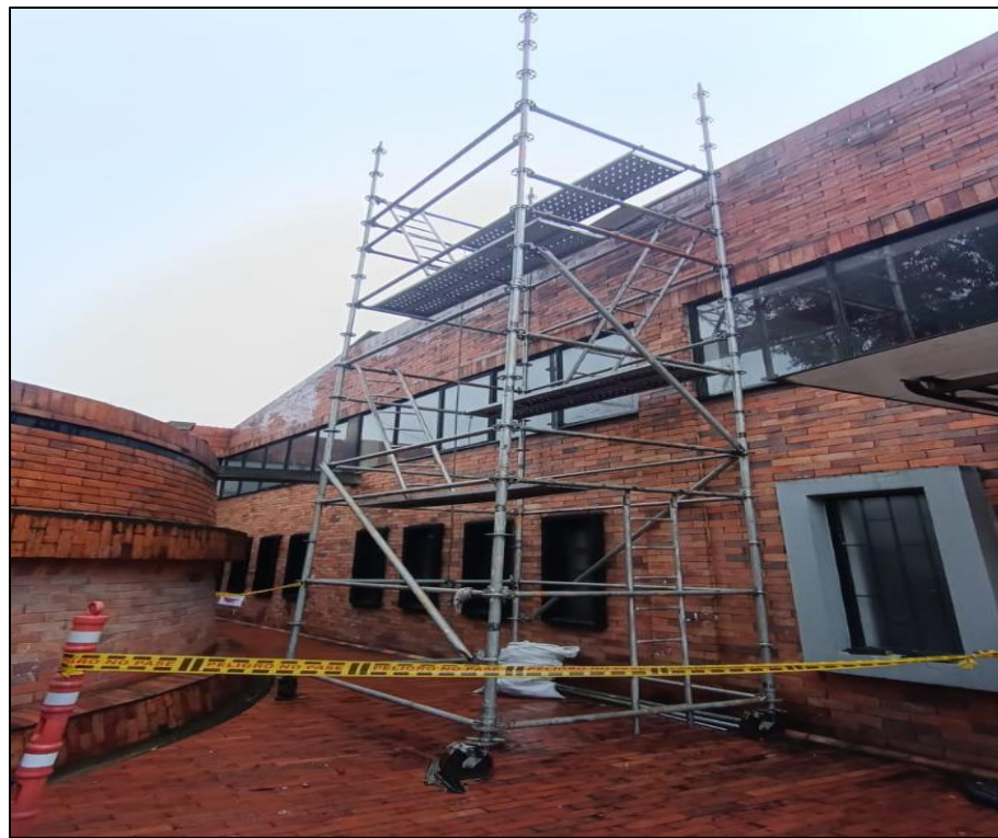
figura 25;Andamio bidireccional con cinco secciones
