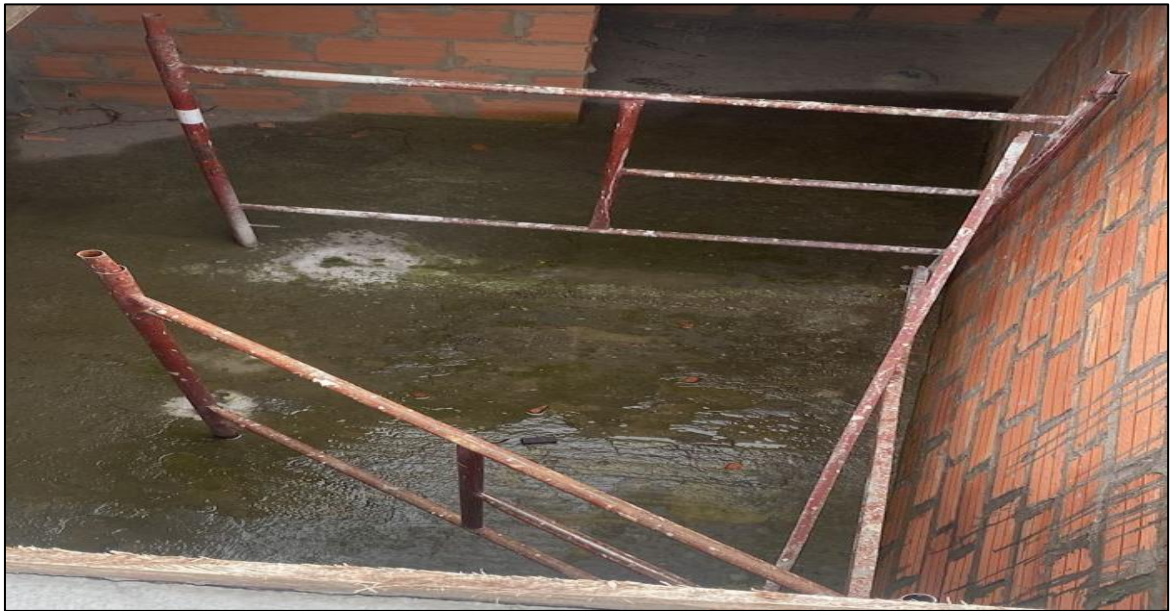
figura 20;Andamios tubular no certificado vista superior
