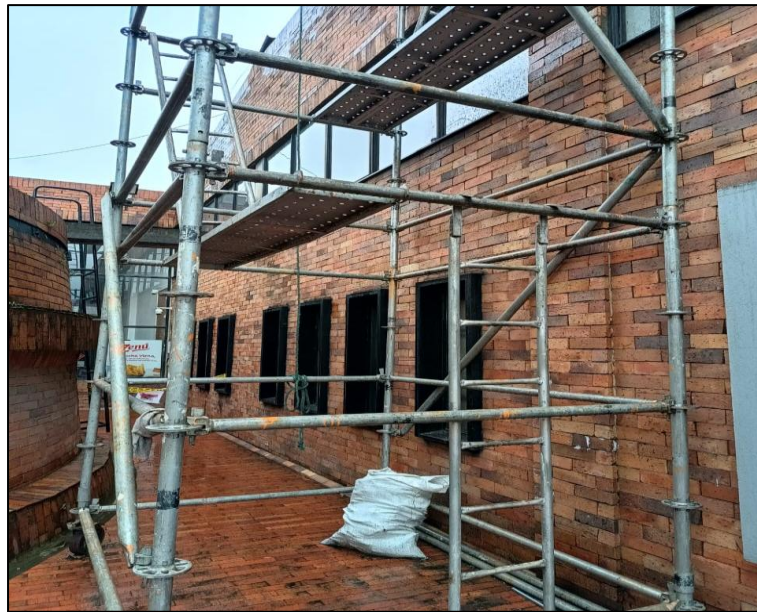
figura 23;Andamio Bidireccional
