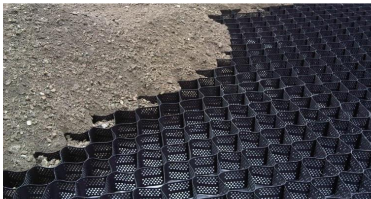
Ilustración 109. Geoceldas utilizadas en la construcción de vías.
