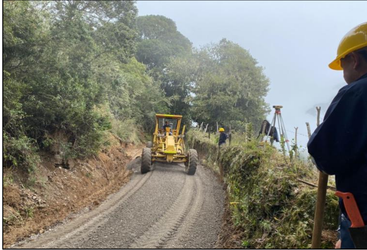
Ilustración 75. Motoniveladora trabajando en el municipio de Málaga-Santander Fuente: Elaboración propia
