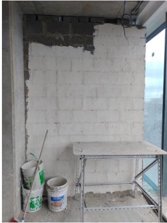
Figura 7. Pañete muro básico. Fuente propia
